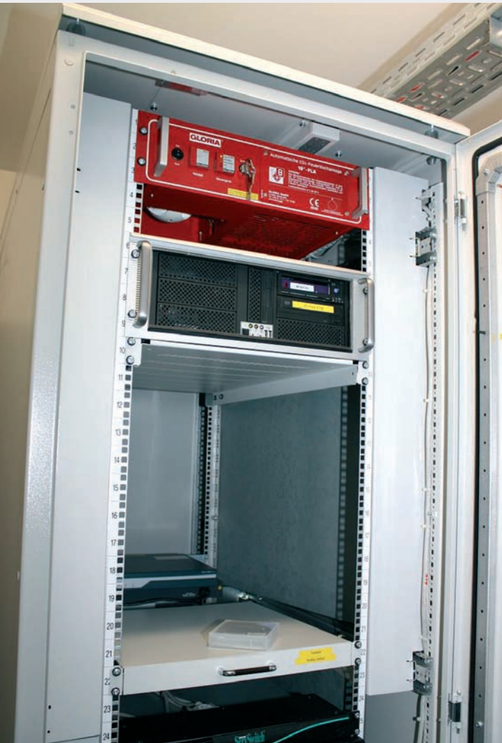
19 Zoll Gaslöschesystem CO 2
